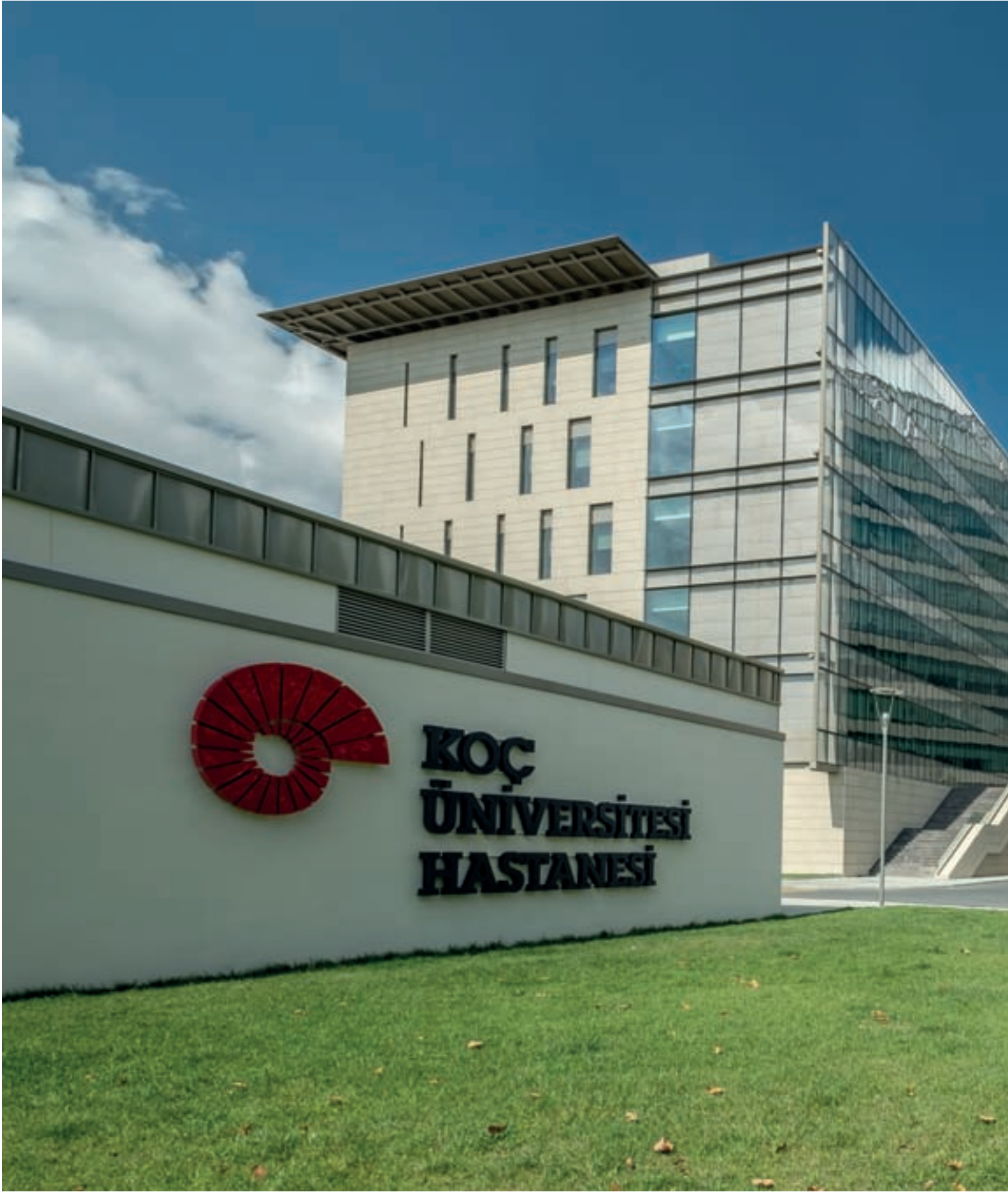
Koç Üniversitesi Tıp Fakültesi Hastanesi Topkapı / İstanbul — Kalesinterflex 3mm Fit Lecesse Grey / Gizli Klipsli Sistem
