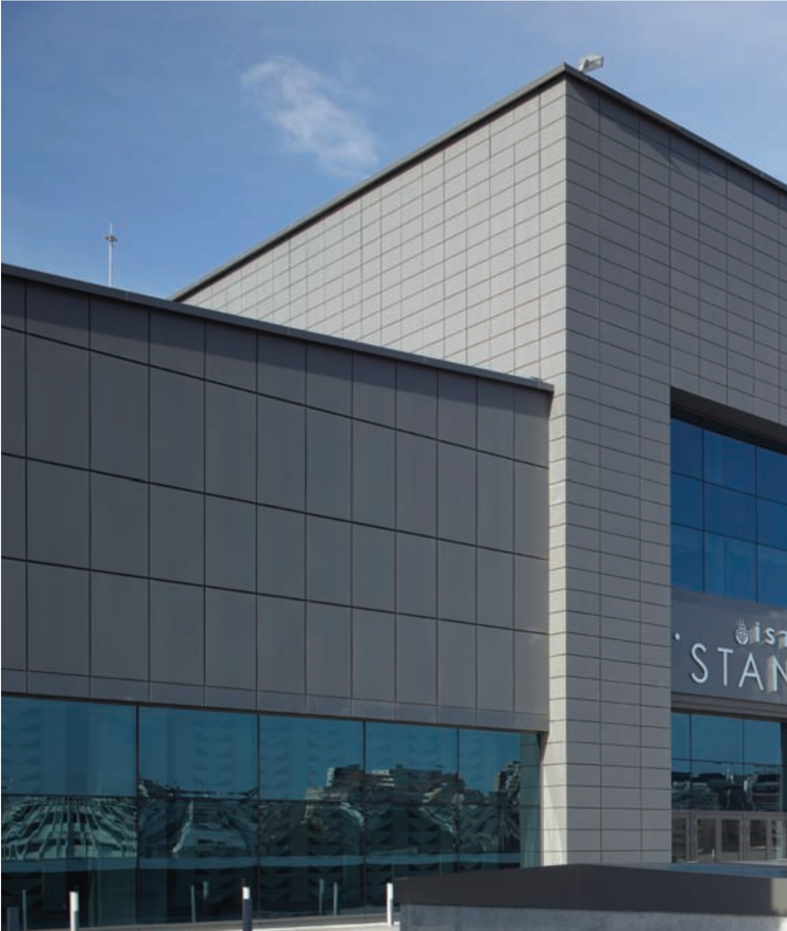
Lütfi Kırdar Kongre Merkezi / İstanbul — Kalesinterflex 3mm Fit Özel Renk / Gizli Klipsli Sistem
