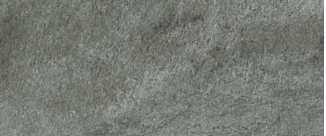
kaya yüzeyi / rock surface
